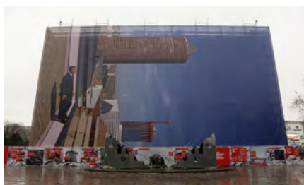
Désamiantage et démolition du B10
